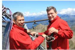
...bei der Installation von Antennen...
